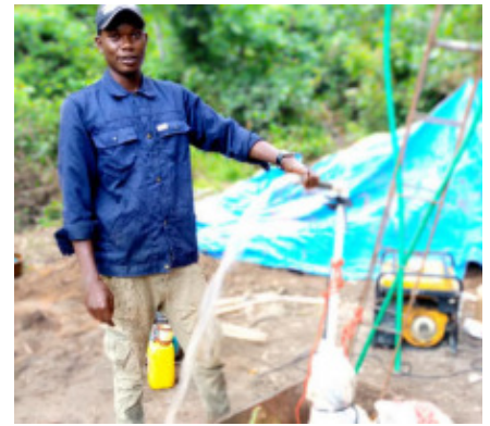
Idiofa, novembre 2022. Perforazione del pozzo: acqua trovata!
