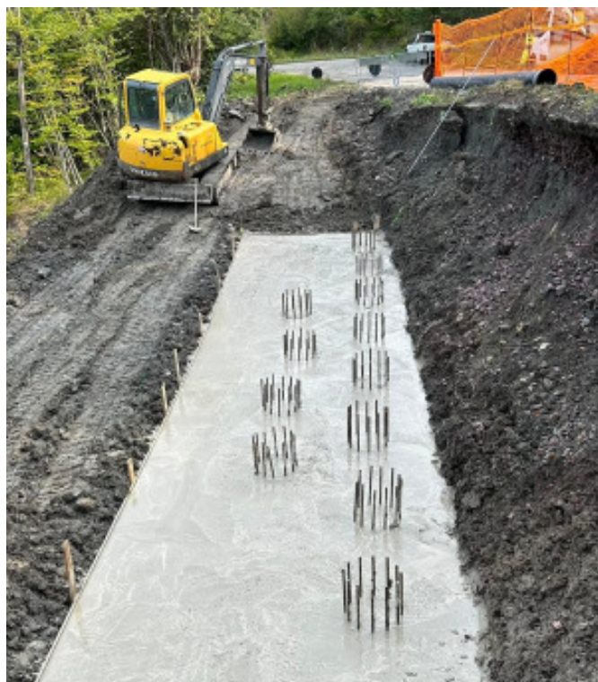
Muro su pali.
