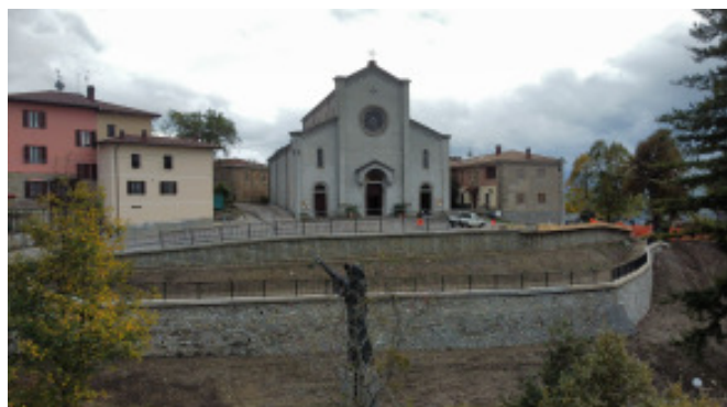
Nuovi muri di contenimento e sostegno piazzale chiesa di Monchio e relative ringhiere.
