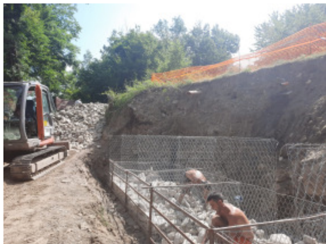
Gabbionata e messa in sicurezza via Costa del fiore
