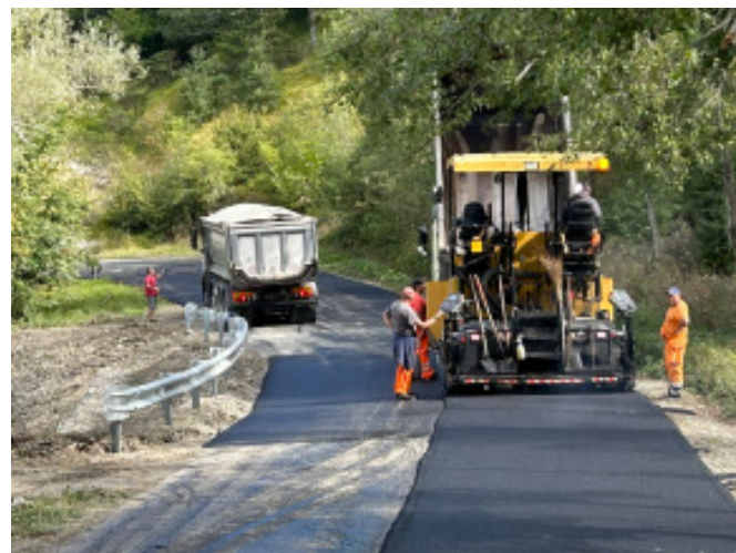
Fine lavori in località Casa Guiglia
